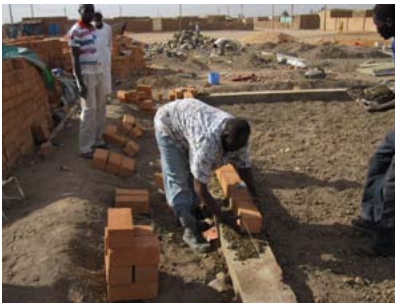
Foto 1 – Bauarbeiten im Zusammenhang mit dem Projekt zur Stärkung der Kapazität des Staates Khartum bei der Konzeption und Umsetzung der Stadtplanung (Sudan)
